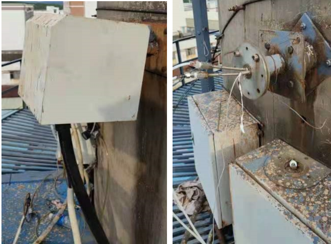
图 2 平台及探头安装图
